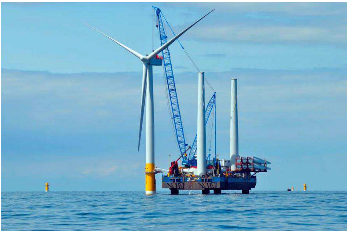
Figura 8. Instalación de aerogenerador en parque eólico marino de Greater Gabbard. 504 MW (Reino Unido)
