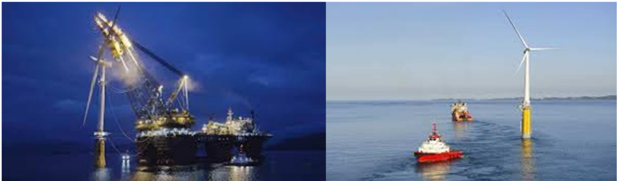
Figura 17. Instalación de aerogenerador en plataforma tipo boya lastrada y procedimiento de arrastre del aerogenerador hasta el emplazamiento.
