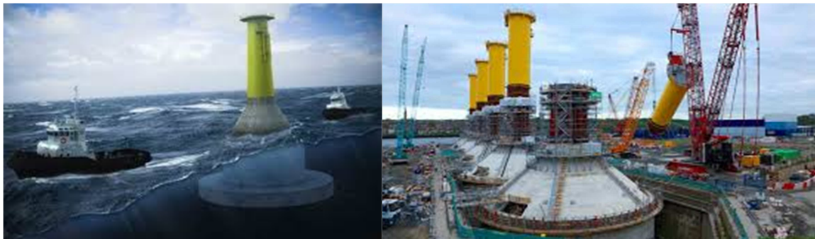
Figura 14. Ejemplos de estructuras soporte por gravedad
