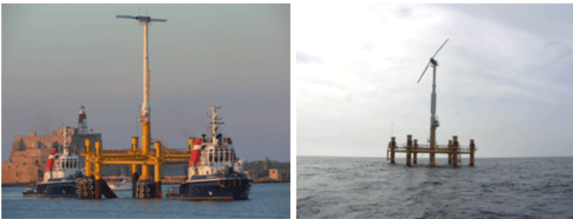
Figura 15. Ensayo del prototipo de plataforma TLP holandesa Blue-H con aerogenerador WES bipala de 80 KW en el mar Adriático (Italia).
