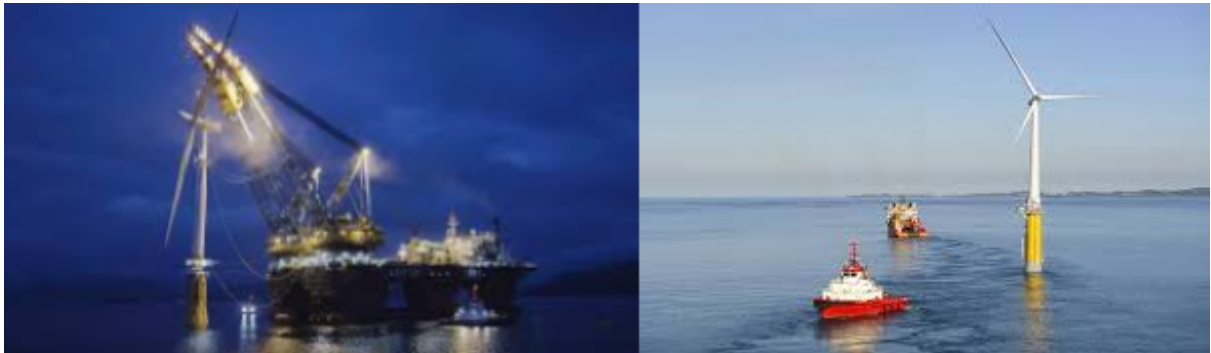
Figura 7. Instalación de aerogenerador en plataforma tipo boya
