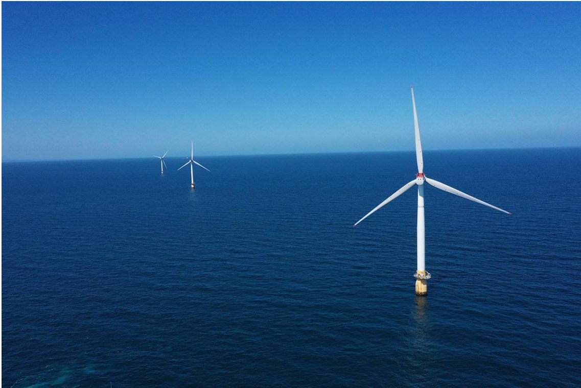
Figura 8. Vista panorámica del parque eólico flotante Hywind Scotland.
