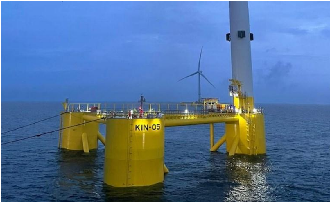
Figura 12. Plataforma flotante KIN-05 del proyecto Kinkardine con aerogenerador de 9,5 MW.
