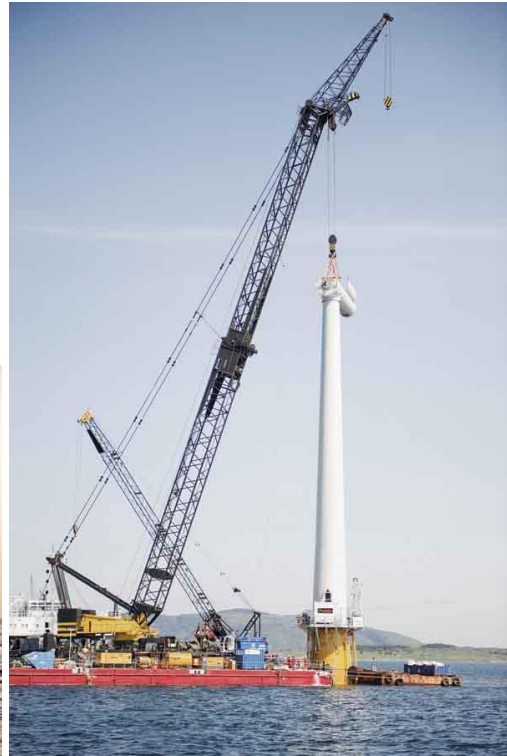
Figura 6. Arrastre e izaje de la plataforma flotante tipo boya e instalación de aerogenerador.
