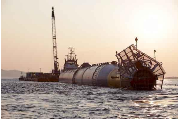
Figura 6. Arrastre e izaje de la plataforma flotante tipo boya e instalación de aerogenerador.
